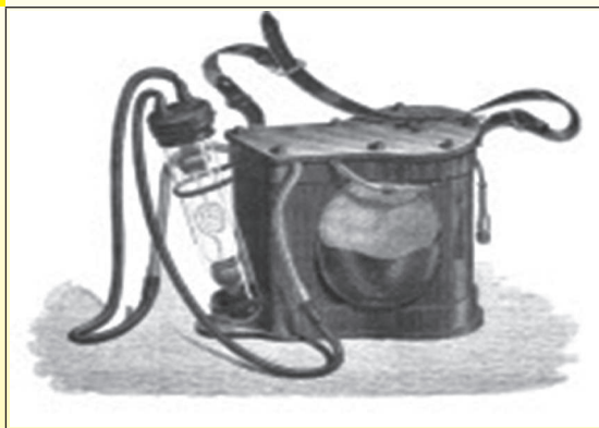
1862年Dumas et Benoit的电矿工灯
